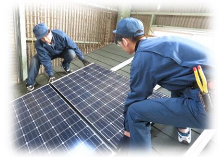
<技専校における太陽光パネル設置訓練>
