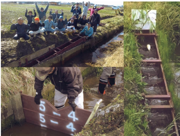
FFU端材を活用した魚道の設置と魚の遡上観測
