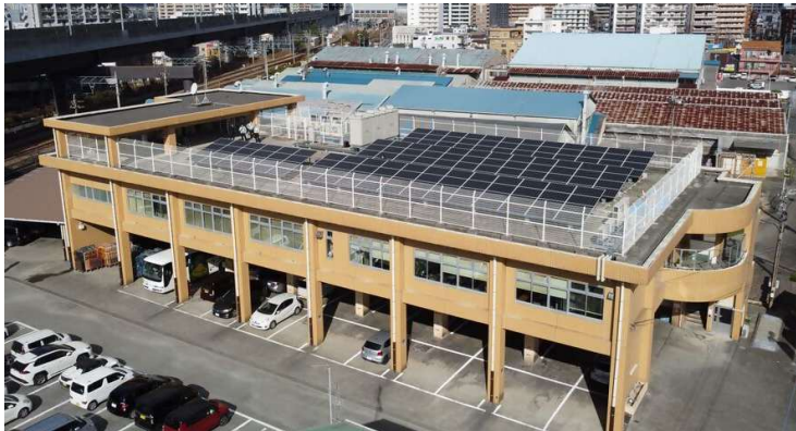
屋根置き型太陽光発電設備の導入例（久留米市環境部庁舎）
