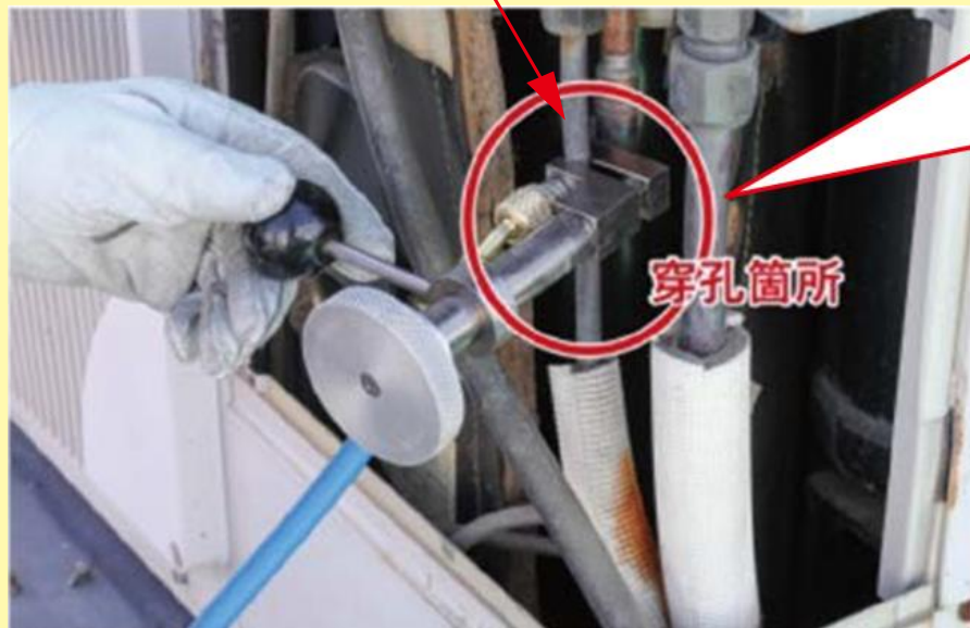
室外機の配管に穿孔している様子
