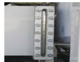
冷媒液面の低下
