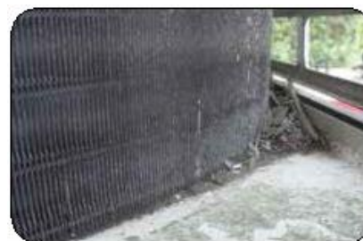
熱交換器下部の腐食
