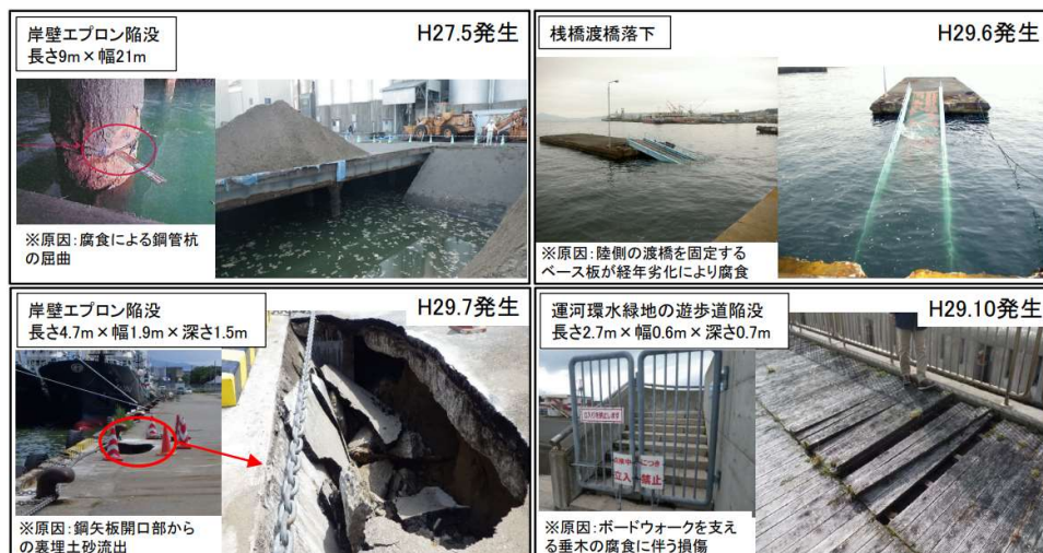
図 4.14 港湾施設の劣化・損傷事例
