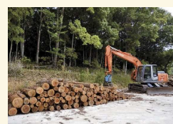
集出荷場(土場の舗装)
