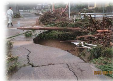
<本木川の被害状況>
