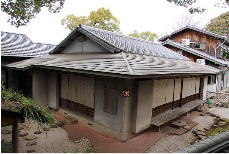
写真 1 大正寺積翠庵茶室外観 (北九州市提供)
