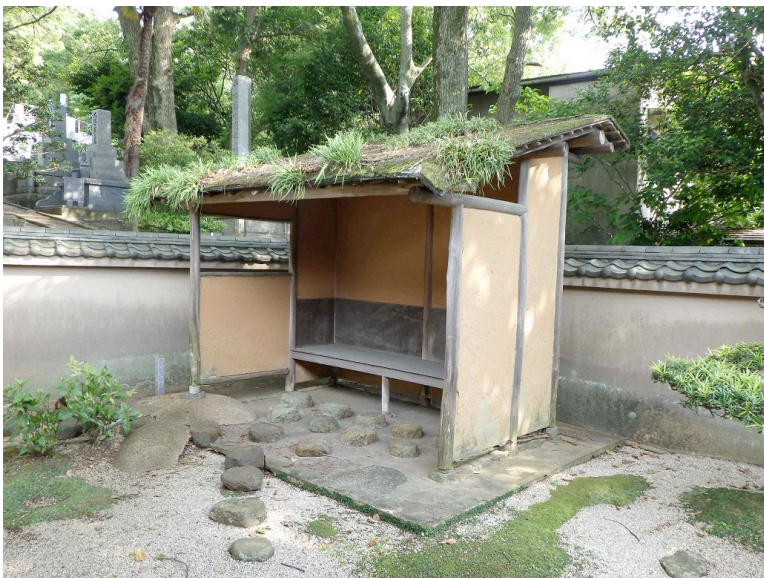
写真 3 大正寺積翠庵腰掛待合 (北九州市提供)
