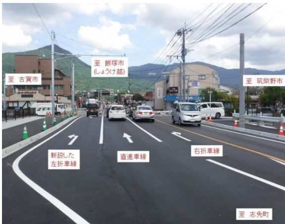
■既存交差点の改良整備
