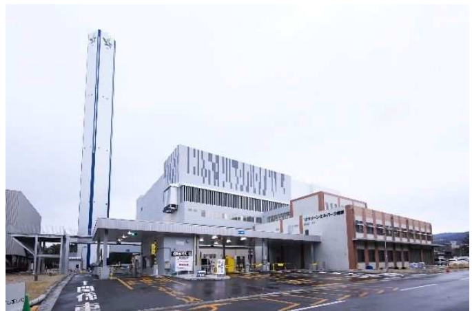
■周辺景観に配慮した廃棄物処理施設 (春日市クリーン・エネ・パーク)
