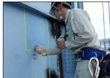
腐食劣化診断の様子
