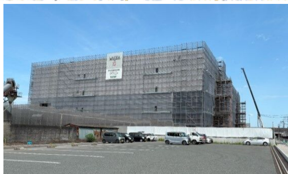
佐賀県鳥栖市 (大型物流施設建設中)
