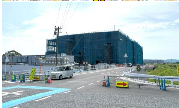
佐賀県基山町 (大型物流施設建設中)
