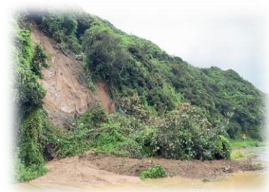
<被災した道路>
