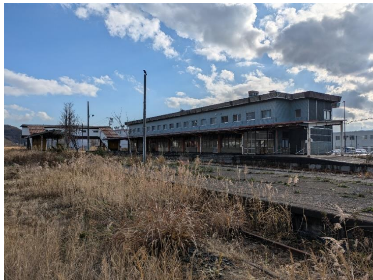
留萌駅の駅舎（ホーム側）
