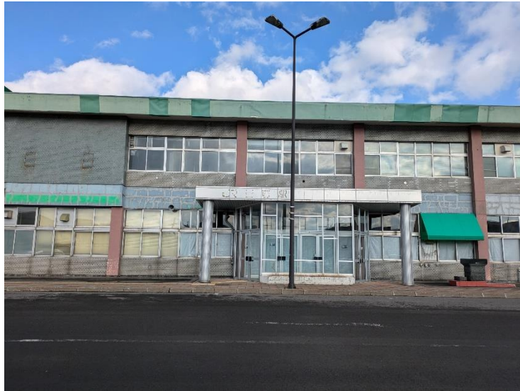
留萌駅の駅舎（ロータリー側）
