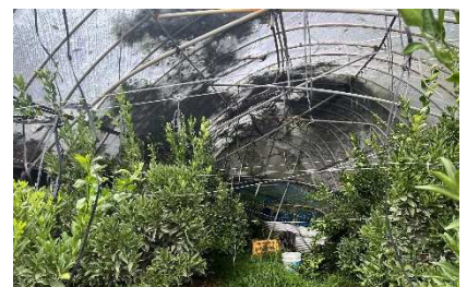
▲被災したハウス施設
