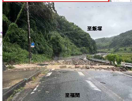
土砂崩れ 全面通行止め 8/10 19:50～ (主) 飯塚福岡線（宮若市～福津市）
