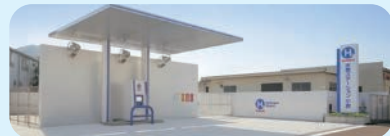
水素ステーション
