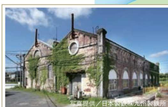
遠賀川水源地ポンプ室
