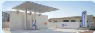
水素ステーション
