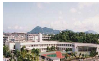
(写真:リハビリテーションセンター全景)
