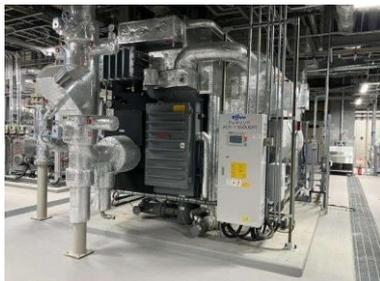
▶ガス吸収式冷温水機
