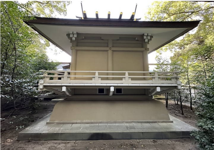
写真 5 福岡縣護国神社本殿 背面外観 (福岡市提供)
