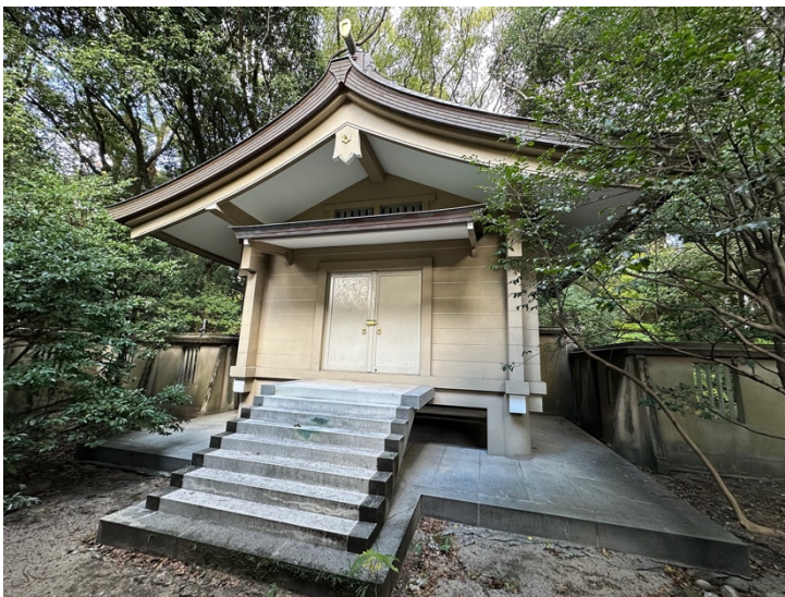
写真 6 福岡縣護国神社奉安殿 正面外観 (福岡市提供)
