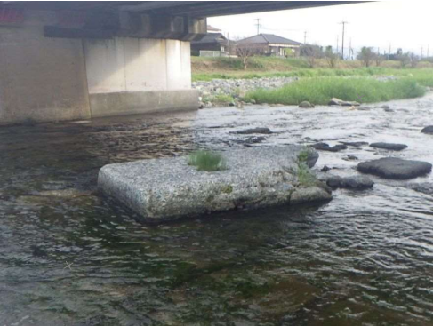
①堰体(崩壊)-1写真
