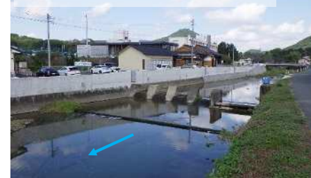
【浸水対策工(南関町関町地内)】
