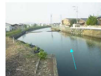
蔵丸橋より下流の状況(護岸工事後)
