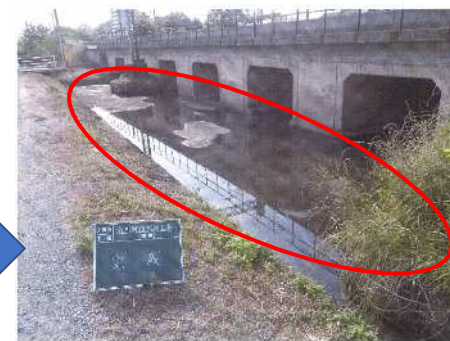
伐採・浚渫後①
