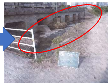
伐採・浚渫後②
