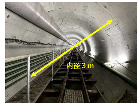
施工状況(シールド工法)
