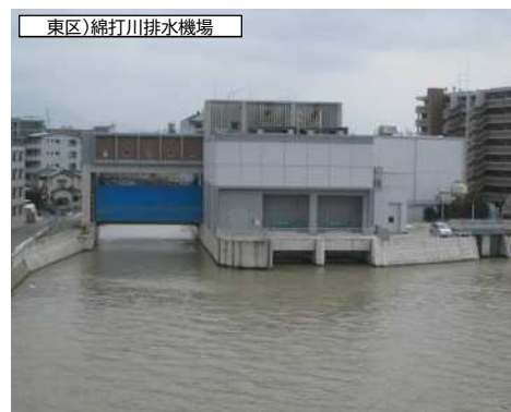
東区)綿打川排水機場
