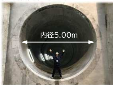
中部2号幹線最下流部
