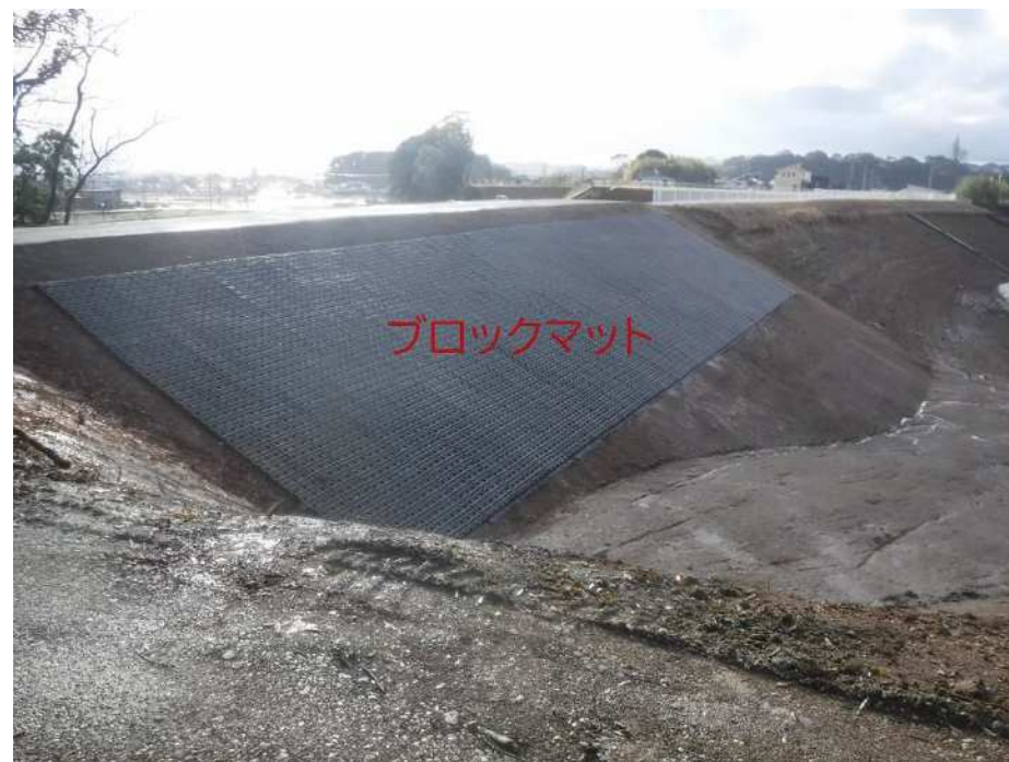
池上池 堤体改修写真
