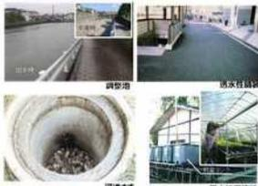
雨水貯留浸透施設の例
