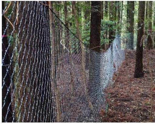
写真1 誘導柵設置状況
