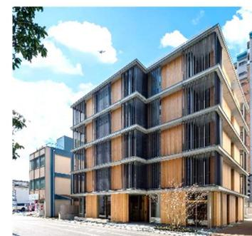
▲CLT（直交集成板）を使用した建築物
