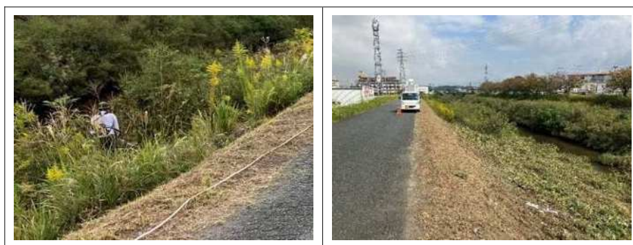
図7-1-2 対策区間における除草作業の様子
