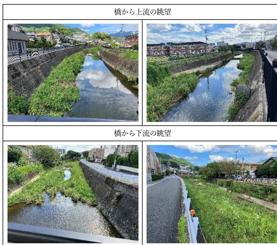
図 4-1-5 白川原橋周辺の概況
