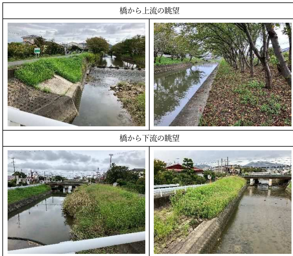
図 4-1-15 仮屋前橋周辺の概況
