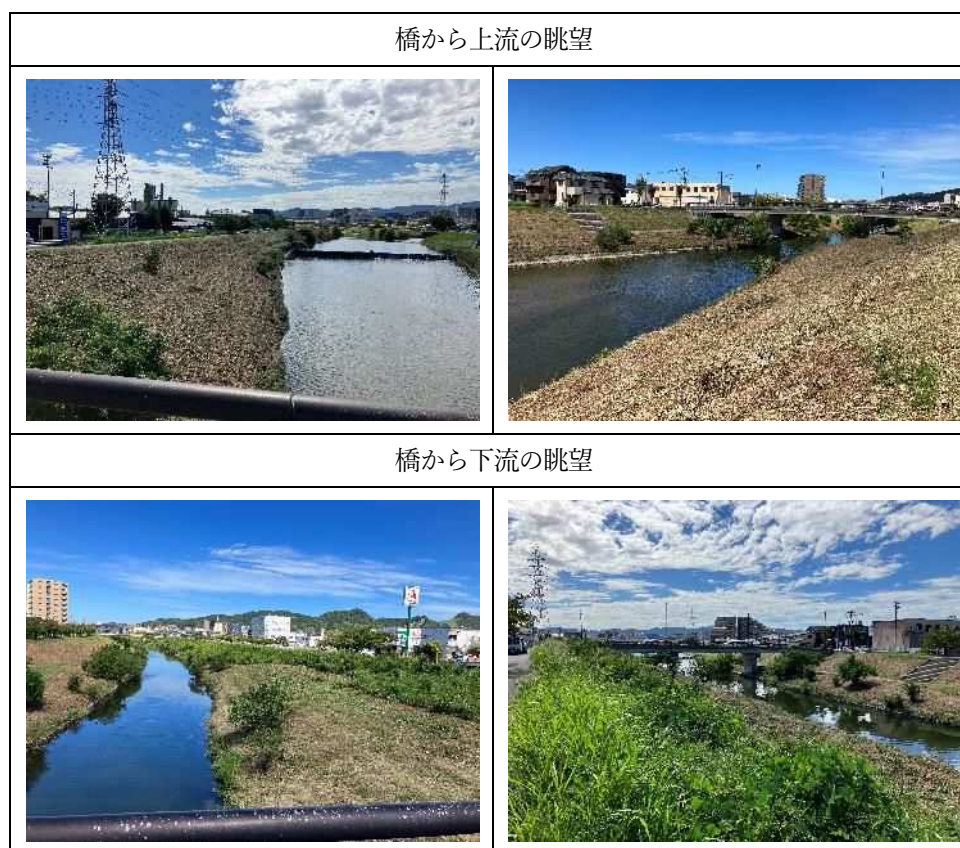
図 4-1-3 筒井橋周辺の概況
