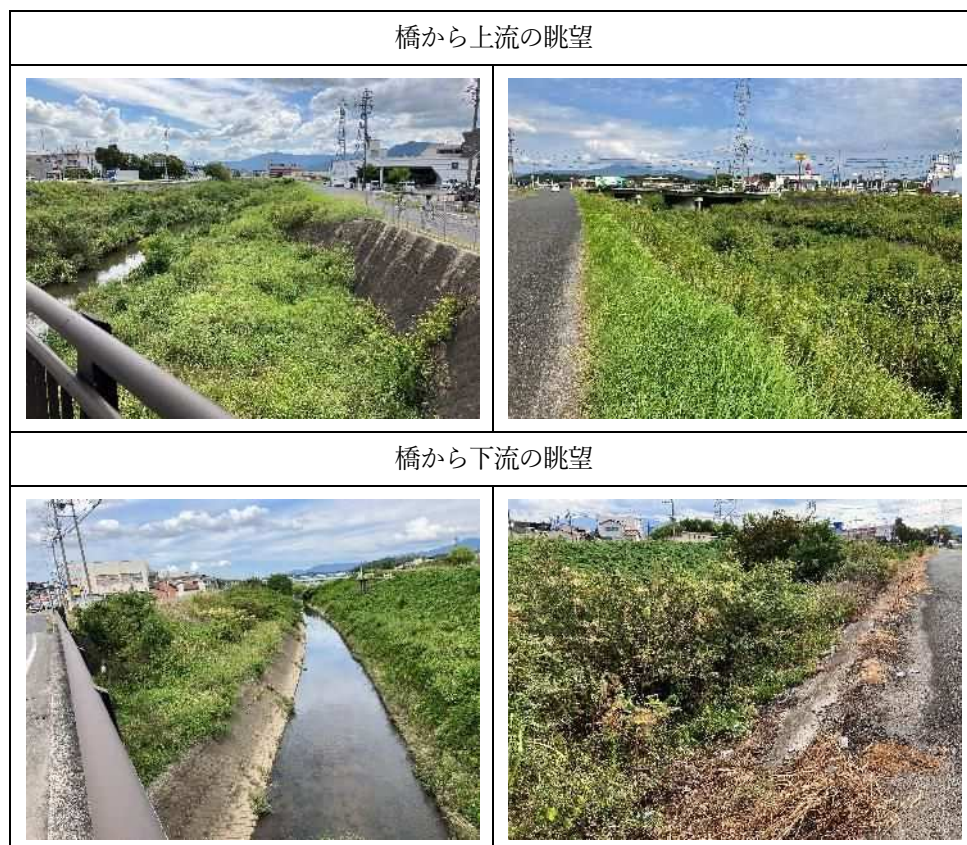
図 4-1-12 二瀬橋周辺の概況
