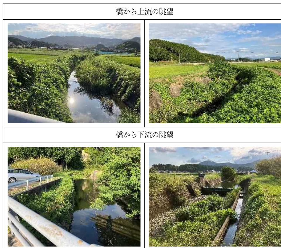
図 4-1-14 立花下橋周辺の概況
