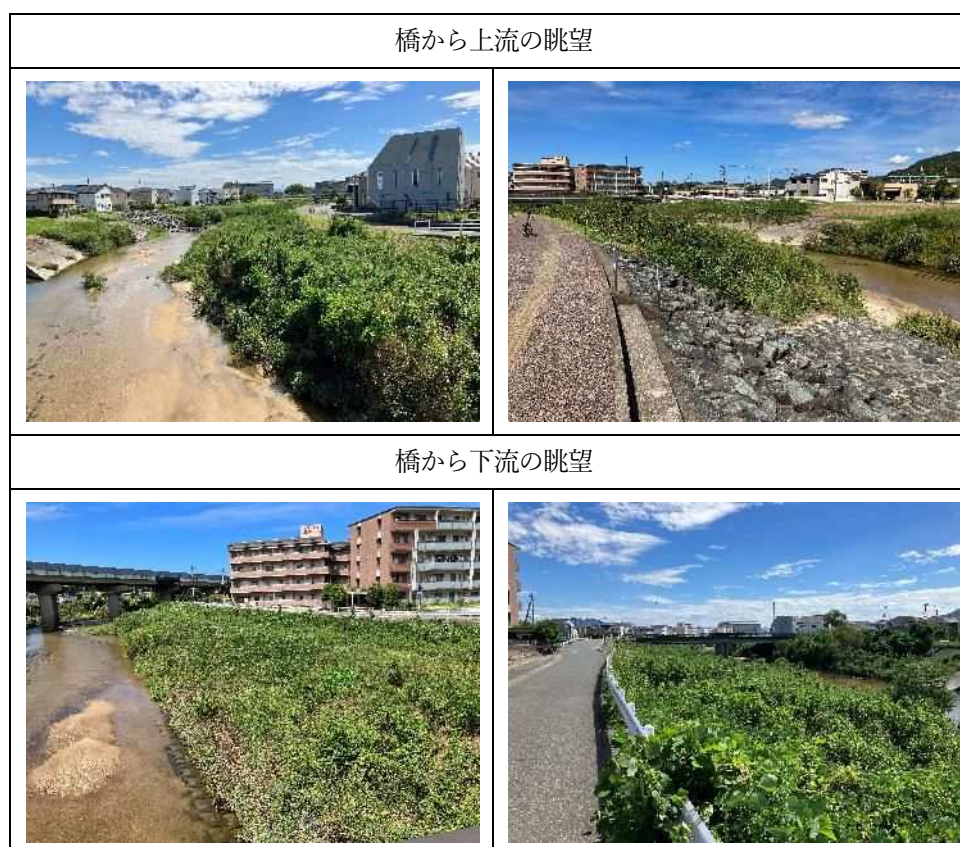
図 4-1-4 下川原橋周辺の概況
