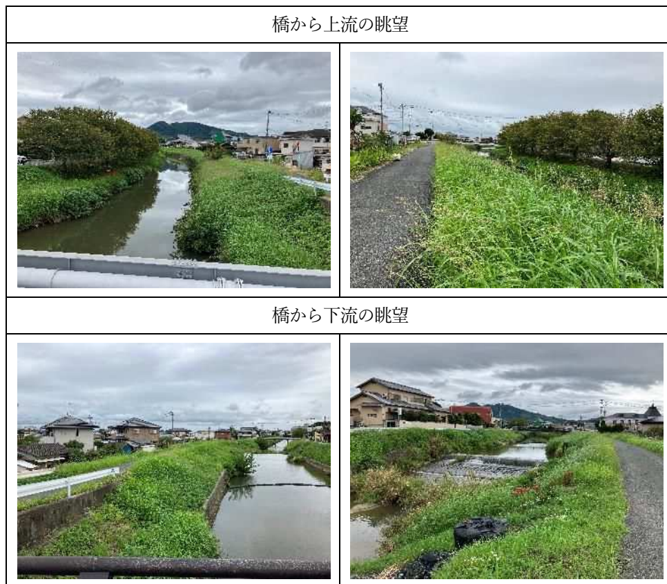
図 4-1-16 七夕橋周辺の概況
