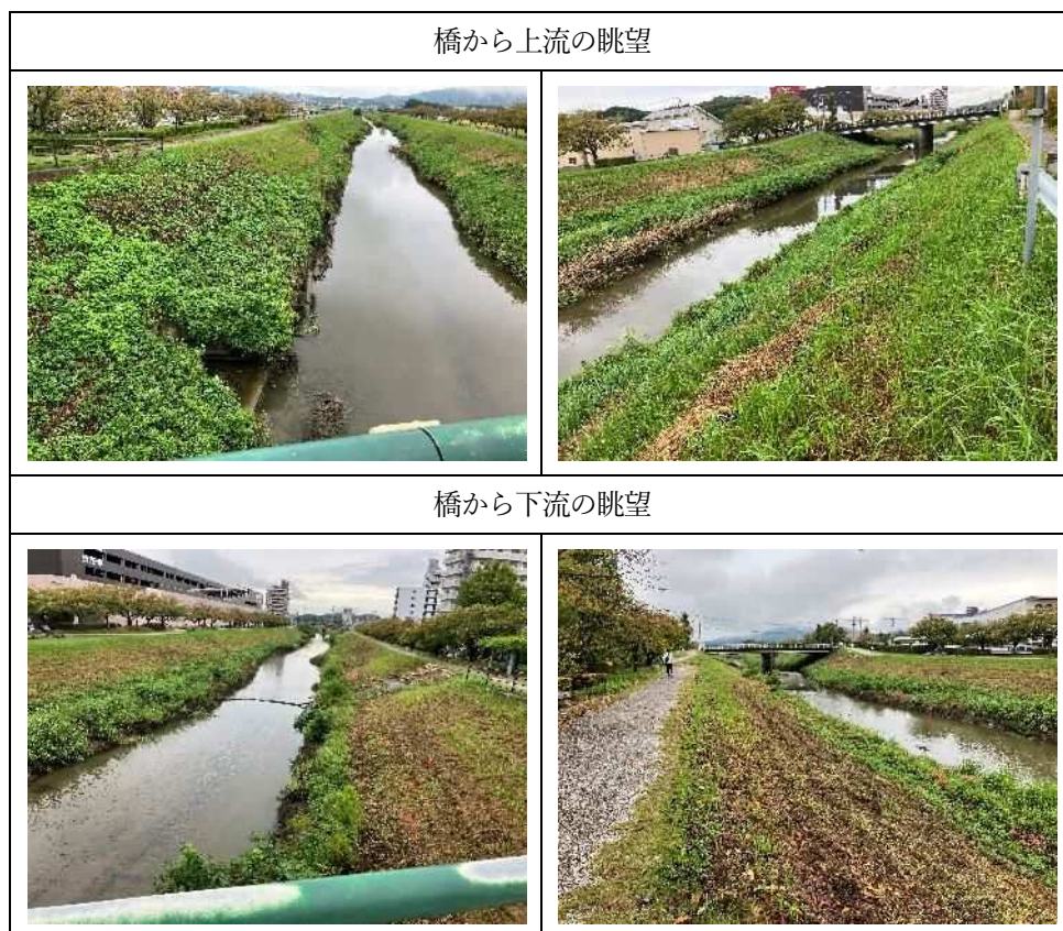
図 4-1-7 赤間大橋周辺の概況
