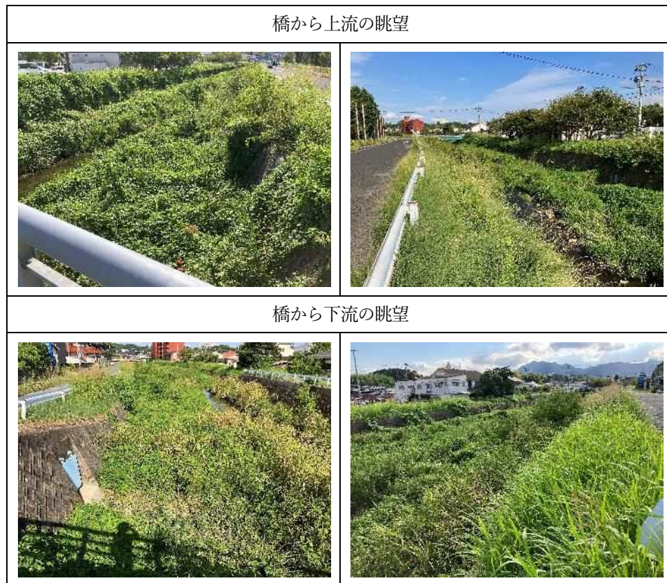
図 4-1-13 伊岐須橋周辺の概況
