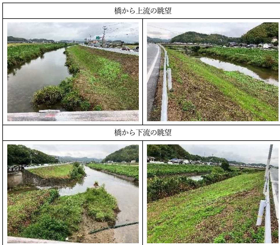
図 4-1-6 河東橋周辺の概況
