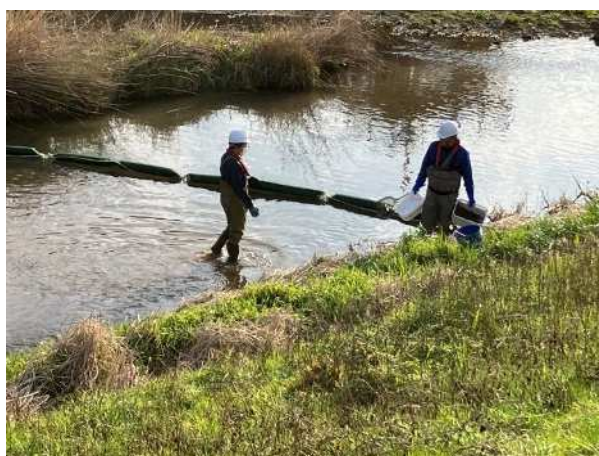
図 1-4-1 河川に立ち入る際の装備（ヘルメット、胴付長靴、ライフジャケット）
