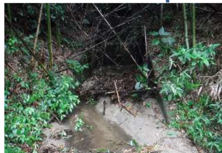
【令和元年施工】 土砂撤去
