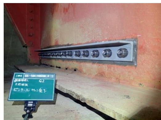
写真-3 補強対策
