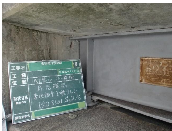
図 4 2010/1/27 (施工中の品質管理)
