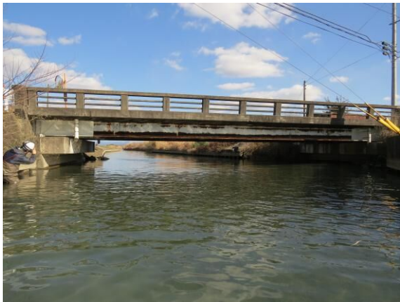
図-5 久富橋 全景
