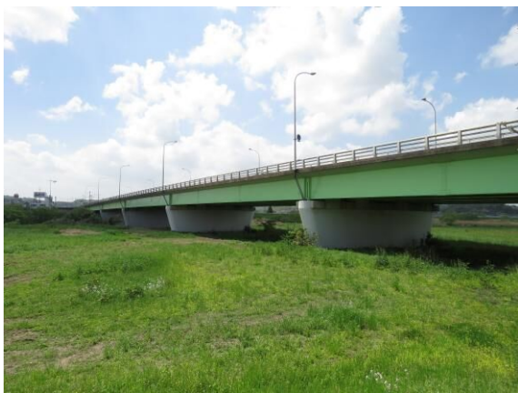
図-7 直方大橋 全景
