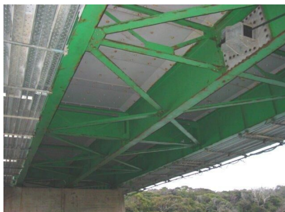
図 2 2008/10 (施工前, 前回塗替え 2 年経過)
