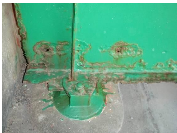
図 3 2008/10 (施工前, 前回塗替え 2 年経過)
