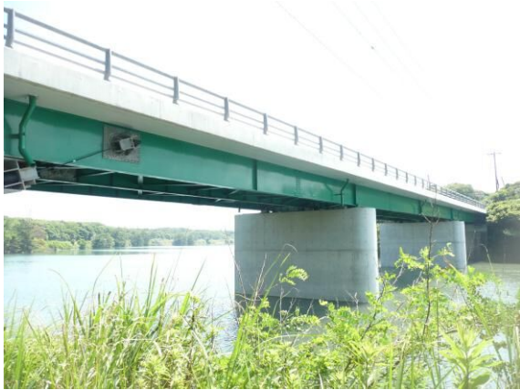
図-3 汐入川橋 全景
