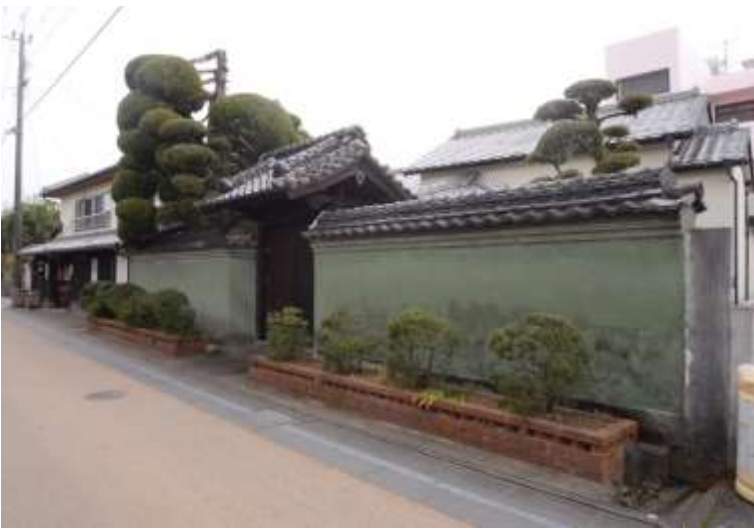
写真5 森田家住宅表門及び北塀 外観 北から (大川市教育委員会提供)
