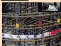
【立会状況（現場側）】
