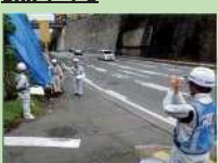
【立会状況（現場側）】
