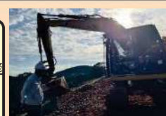
■ICT土木工事現場見学会
