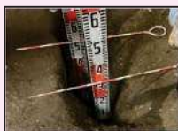
【立会状況（路盤出来形確認）】
