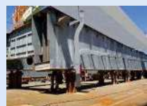
【ARを用いた出来形管理】
