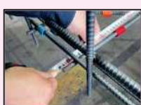
【立会状況（配筋確認：近接）】
