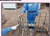
【立会状況（配筋確認）】
