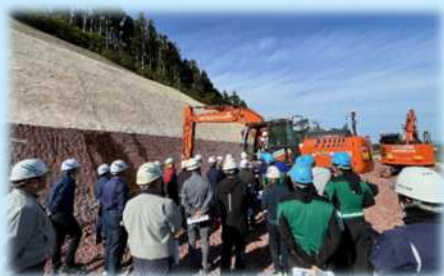
▲ICT土工(切土)の見学
