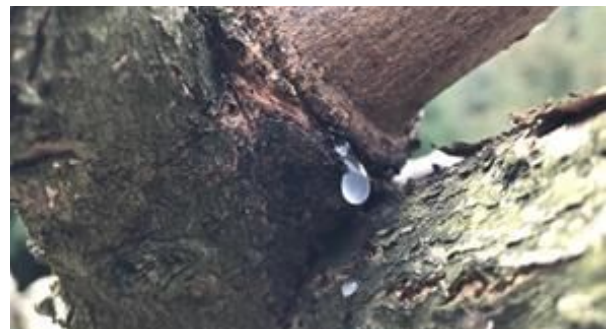
写真2 枝分岐部からの樹液の漏出
