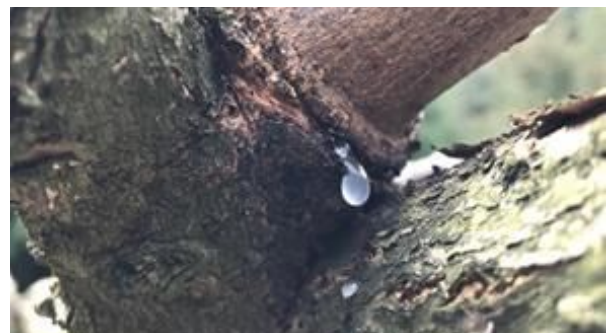
写真2 枝分岐部からの樹液の漏出
