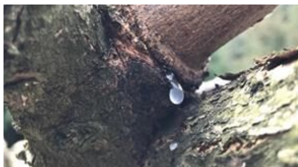
写真2 枝分岐部からの白濁樹液の漏出
