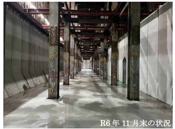
池町川地下調整池（けやき通り）
