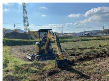
バックホウによる畦畔除去作業
