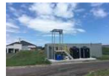
築上町有機液肥製造施設
