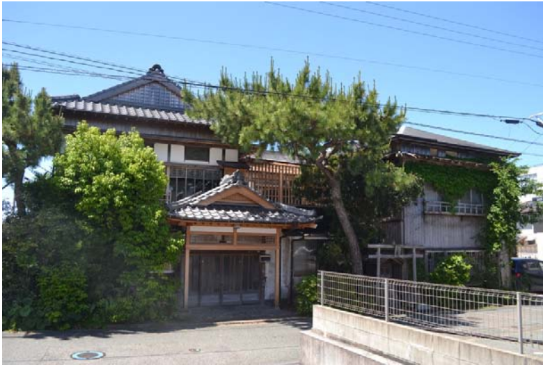
写真 1 旧玉乃井旅館 正面外観 北東から (福津市教育委員会提供)
