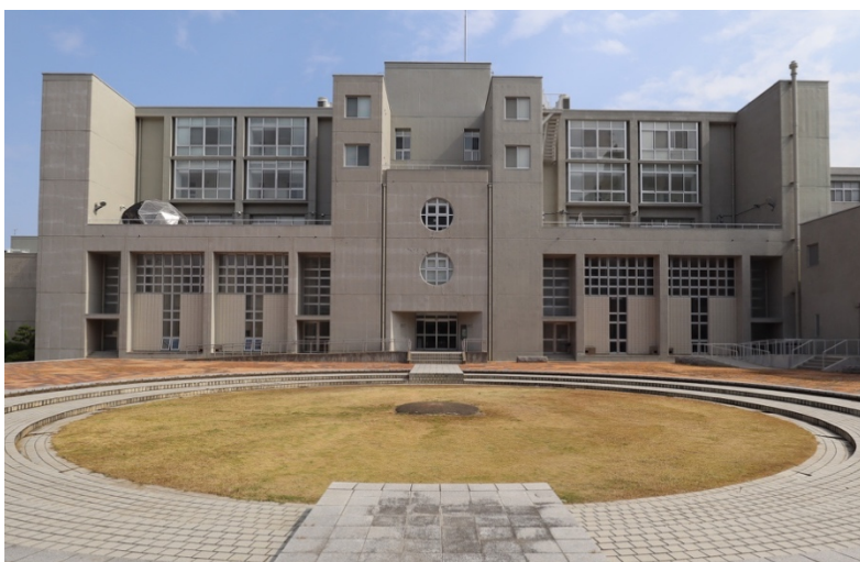
写真 3 旧九州芸術工科大学 環境画像棟 正面外観 (国立大学法人九州大学提供)
