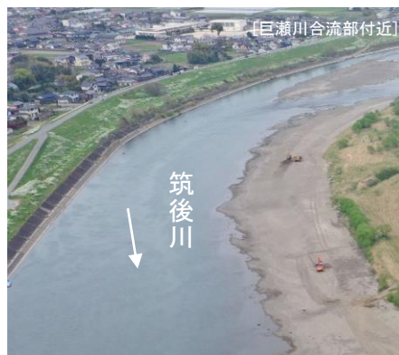
筑後川浚渫状況(久留米市)
