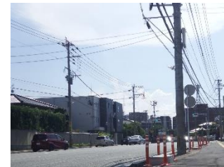
無電柱化（緊急輸送道路）
