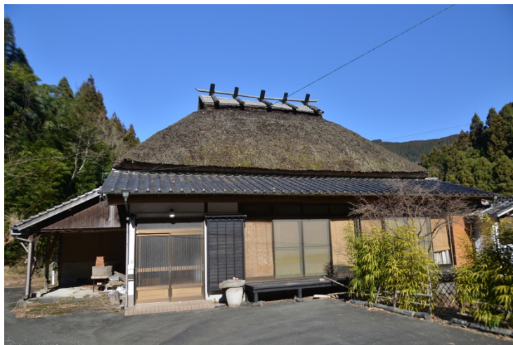
写真2 吉村家住宅 （旧大力家住宅）主屋 正面外観（東から）
