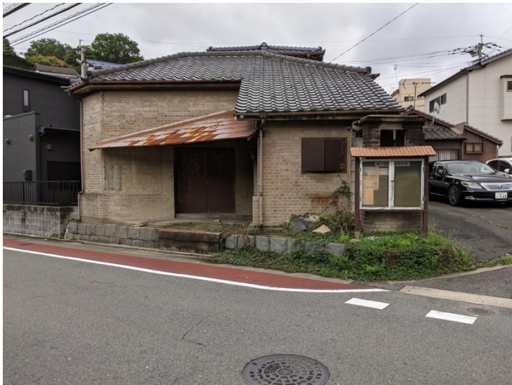
写真 2 田所商店倉庫 外観（北西から）
