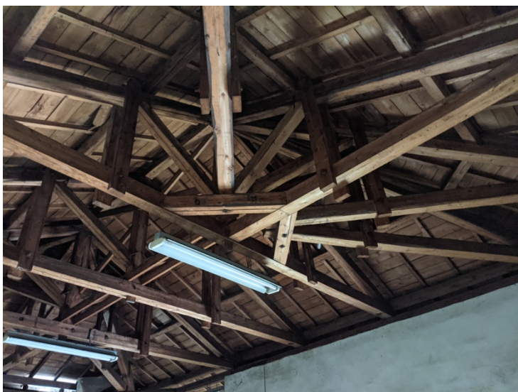
写真 3 田所商店倉庫 小屋組トラス
