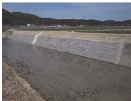
災害復旧工事
