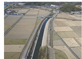
河川の護岸工事
