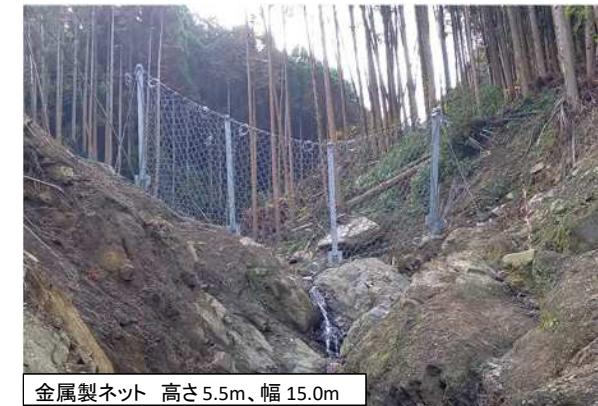
金属製ネット 高さ 5.5m、幅 15.0m
