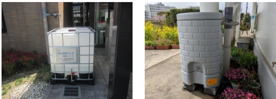
写真 4-29 公共施設への雨水貯留タンク設置状況
