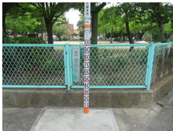
写真 4-25 量水標の設置状況
