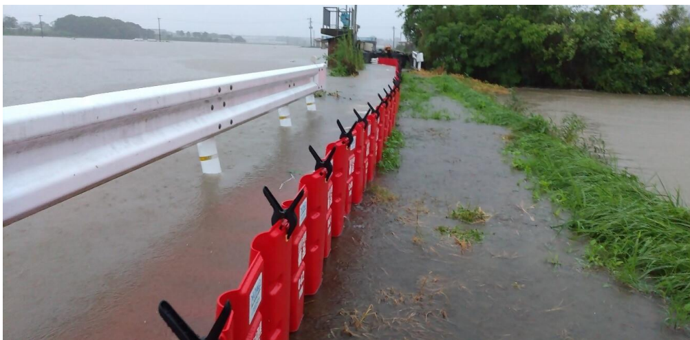
写真 4-31 簡易型止水板の設置状況(筑後市の例)
