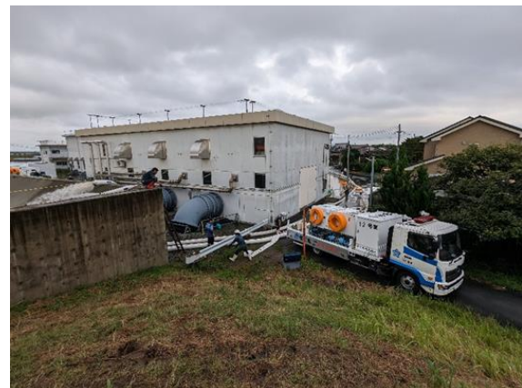
写真 4-21 令和5年7月豪雨における排水ポンプ車の派遣状況(久留米市城島町城島)
